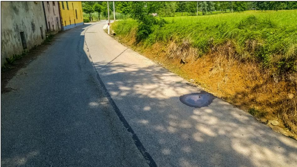
Nell'immagine è possibile osservare il tratto in cui eseguire l'estensione del canale esistente mediante l'aggiunta di un nuovo canale prefabbricato in cls..
