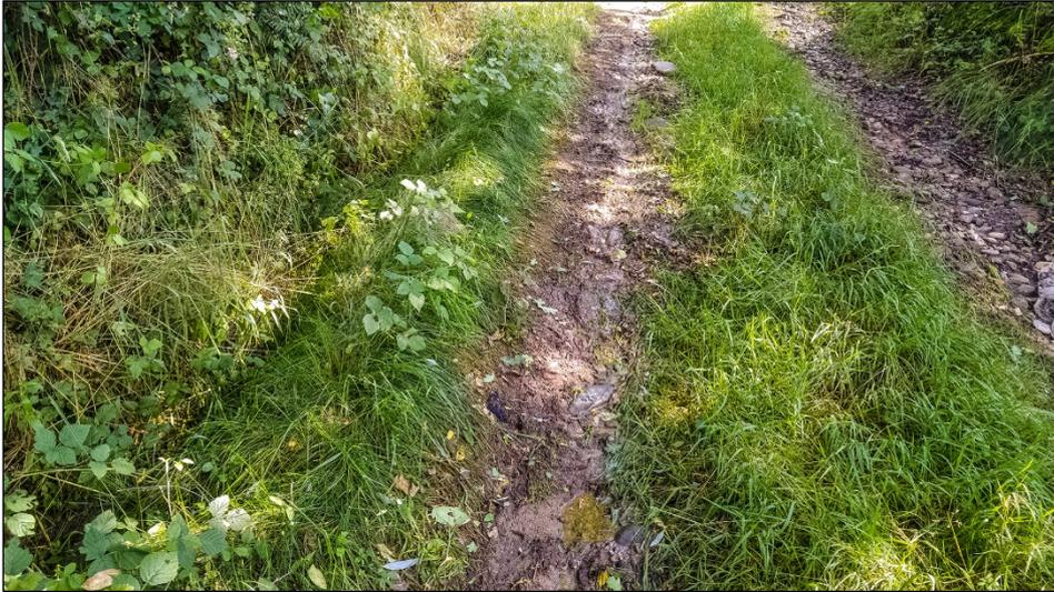
In foto è visibile la pista sterrata per Frazione Vigne Regis; sulla sinistra si intravede il fosso laterale intasato.
