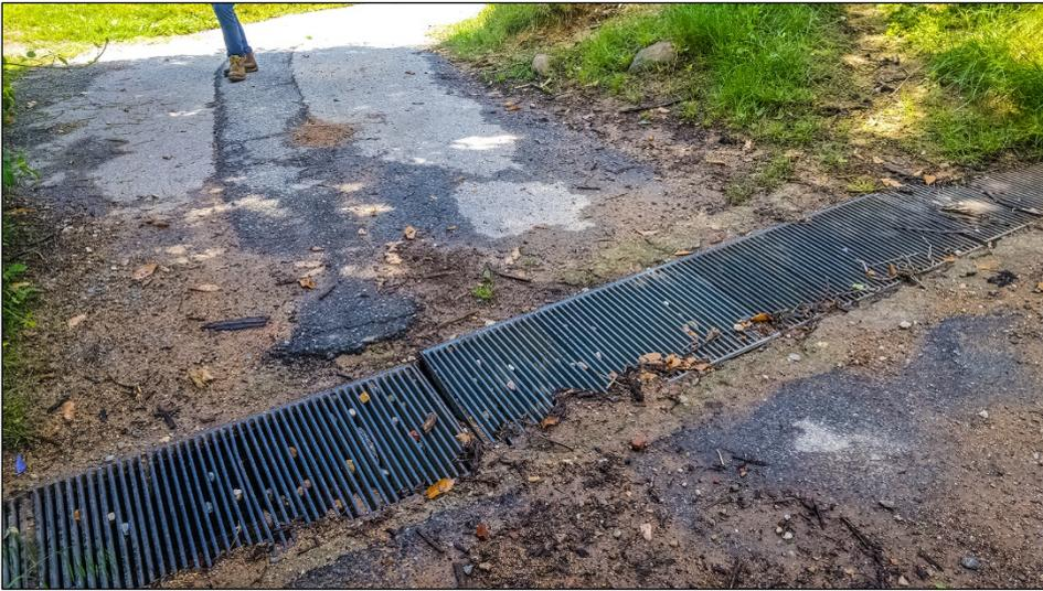
In foto è visibile la canaletta in cemento, provvista di griglia carrozzabile, posta a monte della Borgata Riborgo, di cui si propone la pulizia e l'aggiunta verso valle (lato sinistro della foto) di una tubazione autoportante in cls.
