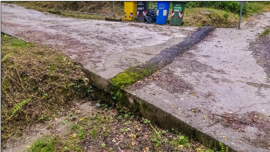
In foto è visibile lo sbocco del tratto intubato per il quale si prevede lo spurgo mediante canal-jet.
