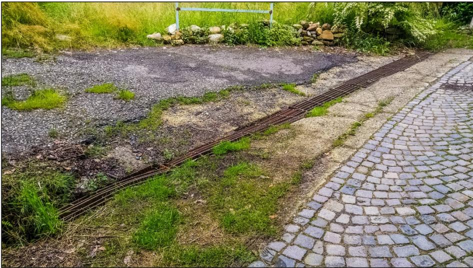
Nell'immagine è visibile la canaletta in cemento e la griglia carrozzabile, entrambe da sostituire.
