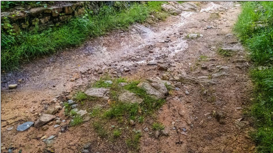
Nell'immagine è possibile osservare il tratto della Via Crucis dove eseguire la messa in opera di canaletta in legno e della tubazione in c.a..
