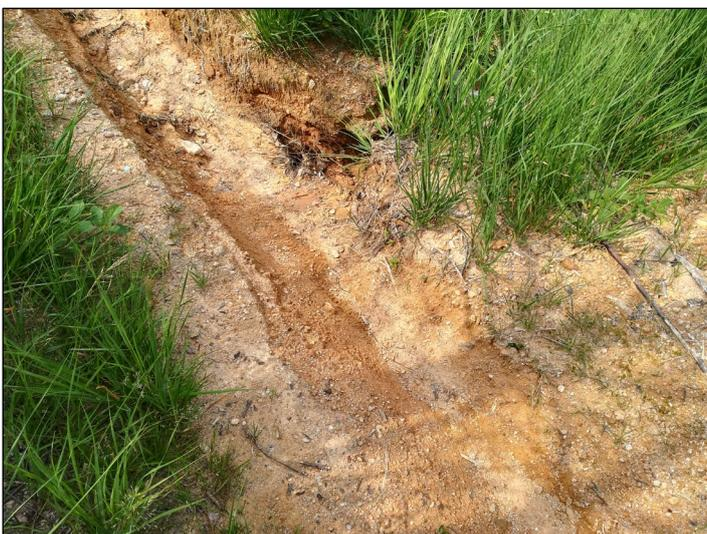
In foto si può vedere uno degli attraversamenti da ripristinare mediante la posa in opera di tubazioni autoportanti in cls. e la realizzazione, lato di valle della pista, di scogliere con vani inerbiti a protezione delle stesse.
