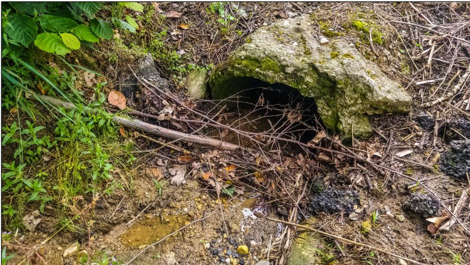
Nell'immagine è possibile osservare la tubazione in c.a., intasata, da sostituire.
