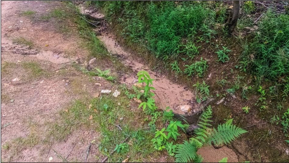
In foto è visibile il tratto di monte della Via Crucis dove effettuare il rifacimento del fosso laterale e la posa in opera di canalette in legno.
