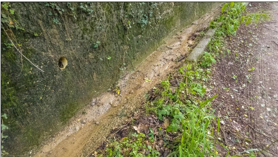
Nell'immagine è possibile osservare la canaletta in cemento, posta a monte del secondo tornante, lungo la quale andrebbe effettuata la rimozione del materiale litoide.
