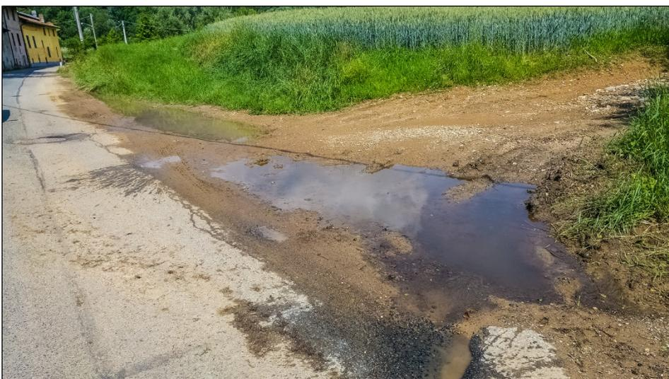
Nella fotografia si può vedere l'area di accesso ai campi agricoli in cui prevedere la posa in opera di una tubazione in c.a., che convogli le acque raccolte dal canale prefabbricato al Rio Marguera, e la realizzazione di una cunetta, da rivestire con elementi prefabbricati in c.a..
