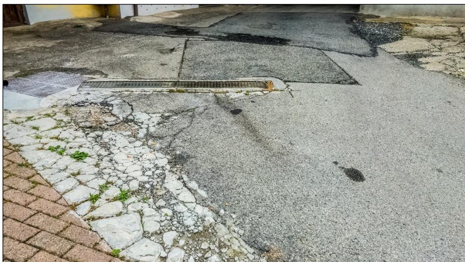
In foto è possibile osservare la canaletta in cemento ed il pozzetto prefabbricato in c.a. sottodimensionati da sostituire.
