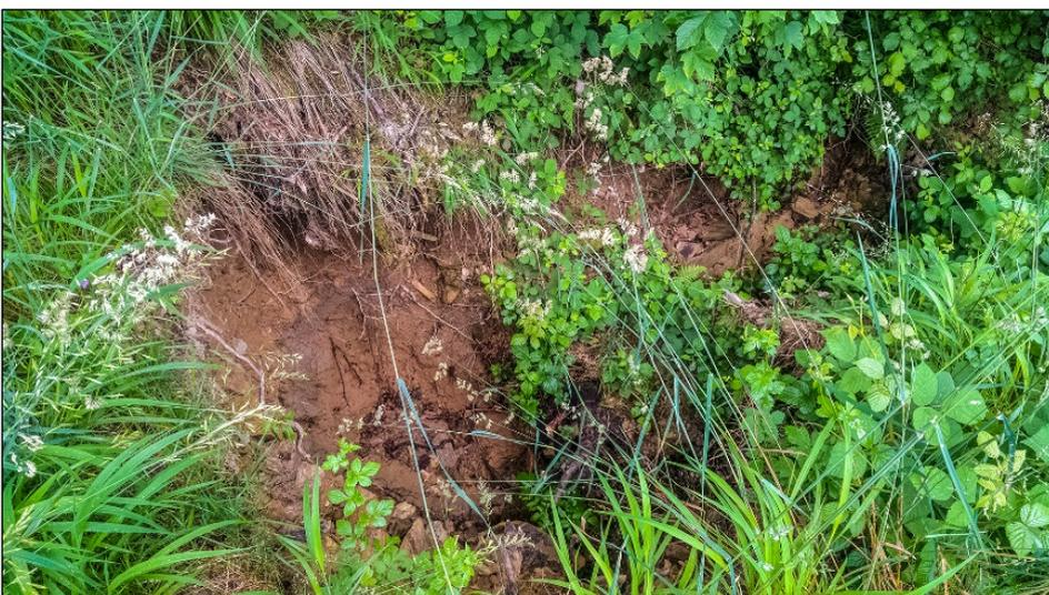
Depressione formatasi lungo la scarpata, ubicata al di sotto del lato di monte della strada comunale ivi presente, a causa dell'erosione operata dalle acque di tracimazione della roggia durante fenomeni di piena eccezionale.
