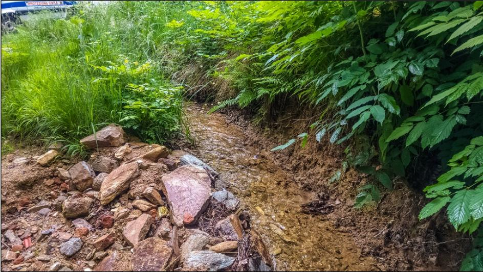
Roggia storica localizzata a monte della Frazione Prataldo. In questo tratto si propone il ripristino delle sponde mediante la realizzazione di scogliere con massi intasati in cls. e l'impermeabilizzazione del fondo dell'alveo, allo scopo di evitare futuri episodi di erosione dello stesso, con la posa di massi e successivo intasamento con cls.
