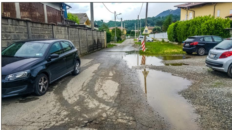
In foto è visibile il punto di Via Villa dopo eseguire la messa in opera della canaletta in cemento e dal quale iniziare la posa della tubazione in PVC.
