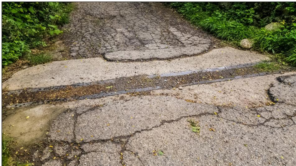
In foto è visibile la canaletta in cemento provvista di griglia carrozzabile da sostituire.
