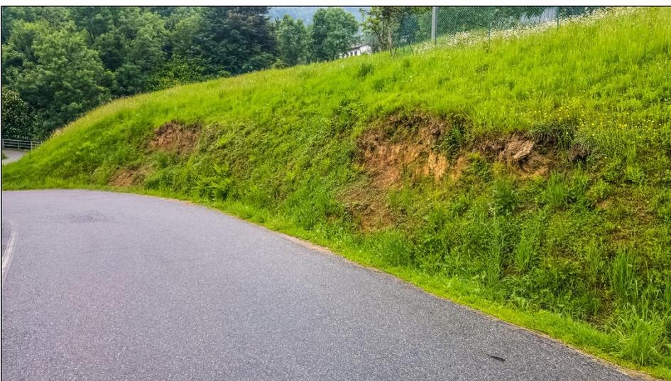
Tratto di versante posto a monte del tornante della Sp43 lungo il quale si ritiene opportuna l'esecuzione di una palificata di sostegno ad una parete, con la posa in opera, alla base della stessa, di un canale prefabbricato in cls. a sezione ovoidale.
