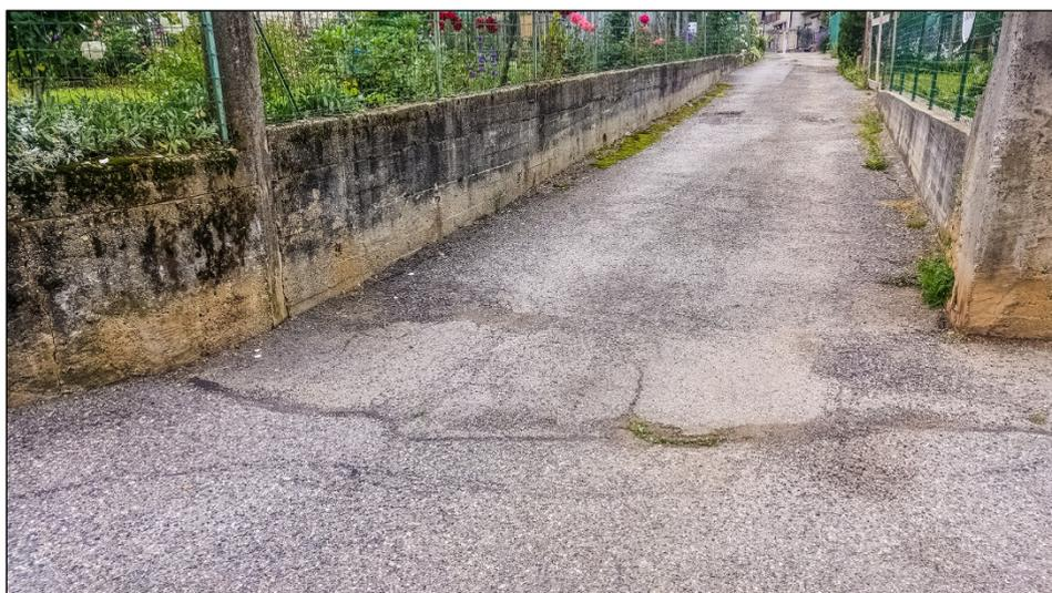
In foto è visibile il punto di Via Villa dopo eseguire la messa in opera della canaletta in cemento e dal quale iniziare la posa della tubazione in PVC.
