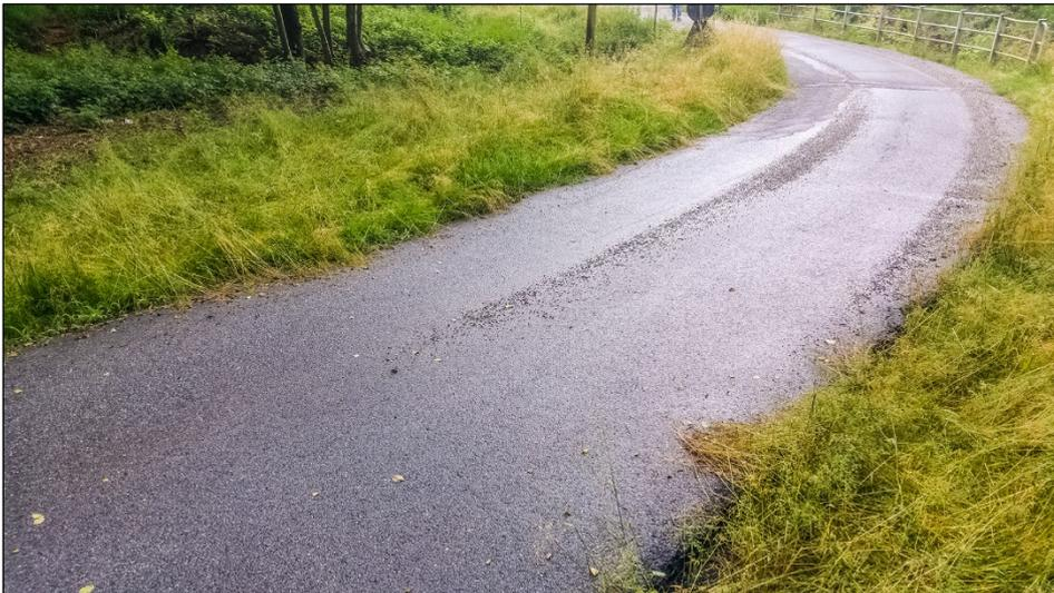
Nella fotografia è possibile osservare il tratto di strada in cui si ritiene opportuna la posa in opera di una canaletta in cemento, provvista di griglia carrozzabile, e di canale prefabbricato in cls..
