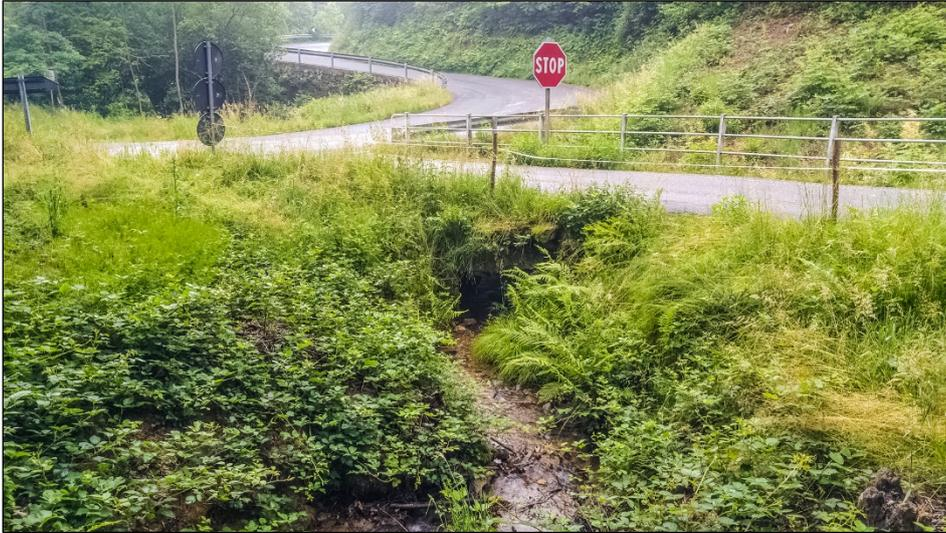
In foto è visibile il tratto del rio posto a monte dell'attraversamento, lungo le cui sponde si propone la realizzazione di scogliere con massi intasati con cls.
