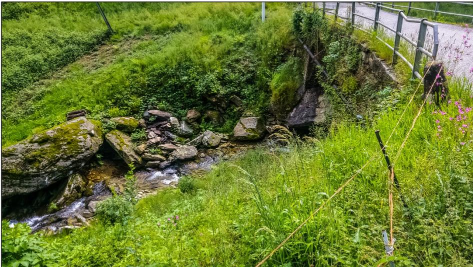
In foto si possono osservare la sponda sinistra, lungo la quale si ritiene opportuno realizzare una scogliera a massi intasati in cls., ed il cordolo in c.a. e la barriera metallica di sicurezza stradale da sostituire.
