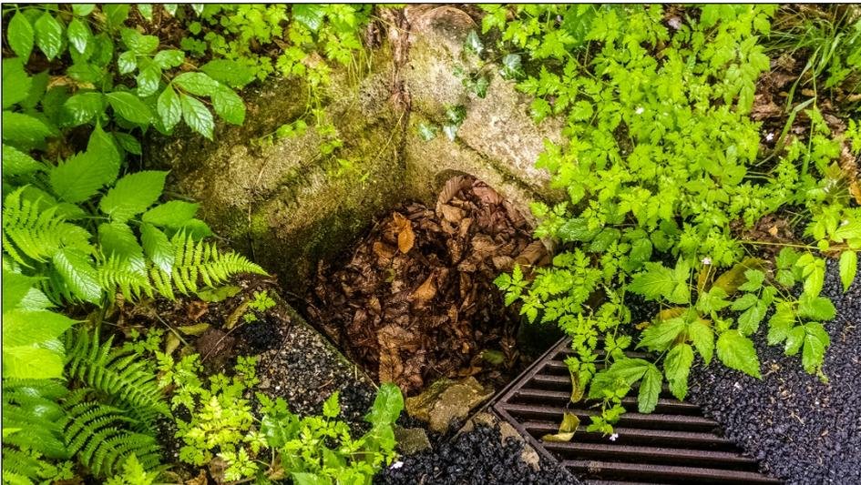
Nella fotografia è possibile vedere il pozzetto prefabbricato esistente sul quale installare un chiusino, cosa da evitare l'intasamento dello stesso.
