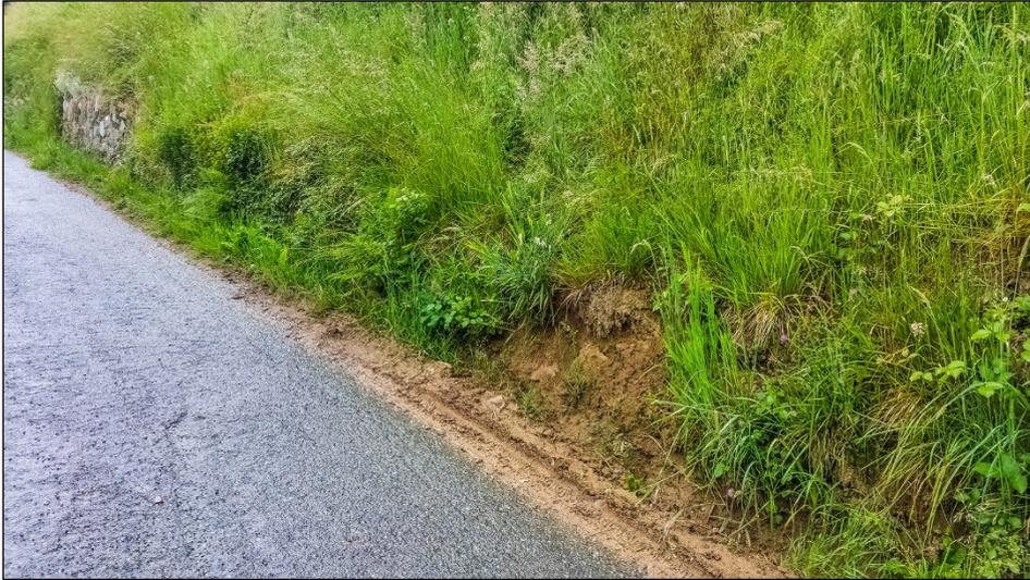
In foto è visibile il tratto di monte del versante, lungo la Sp43, sprovvisto di muratura in pietrame a secco.
