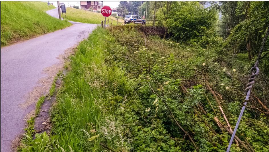
Nell'immagine è possibile osservare il tratto di scarpata a valle della strada comunale che porta a Frazione Fogliasso di Canischio lungo la quale si propone di realizzare una scogliera di sostegno a massi intasati con cls..
