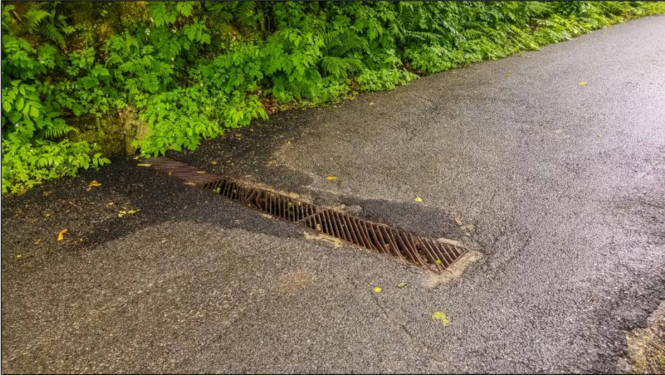
In foto è visibile una delle tre canalette in cemento, provvista di griglie in ghisa sferoidale carrozzabili, sulle quali sarebbe necessario effettuare la pulizia e l'adeguamento dimensionale rispetto alle reali dimensioni della sede stradale. Si può inoltre osservare come le griglie esistenti siano danneggiate e quindi vadano sostituite.
